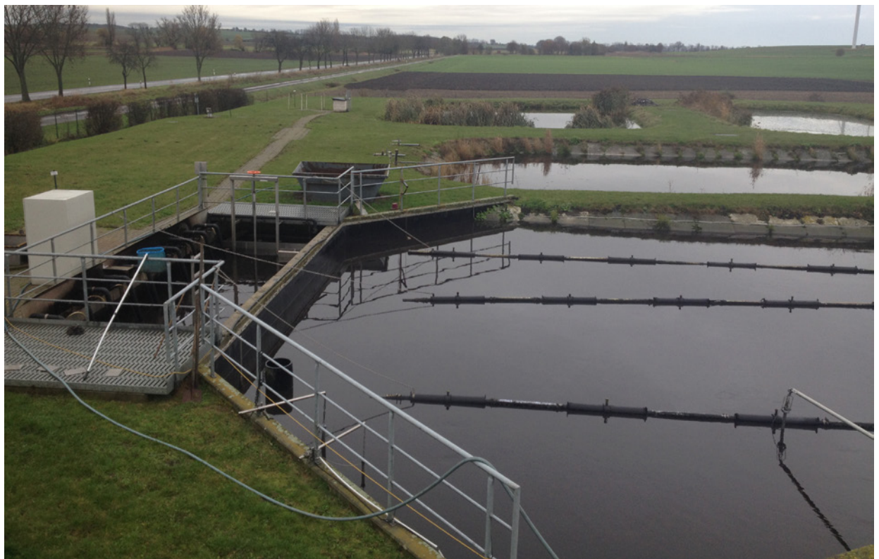
Bild 1: Belüftete Teichkläranlage Söllingen vor Umbau [1]
